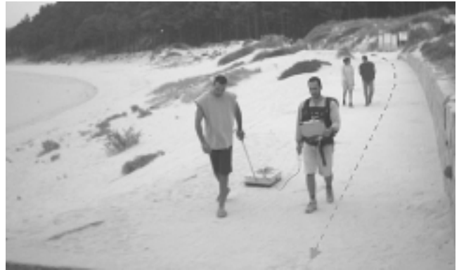
Fig. 7. Toma de datos en las Islas Cíes con una antena apantallada de 250 MHz. La flecha indica el eje del vial sobre el que se efectuó el estudio, constituido por losas de hormigón que permanecen ocultas bajo la arena.
